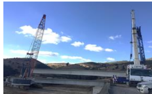
Figure 1 : Pose de poutres par grues Figure 1: Installation of beams by cranes
