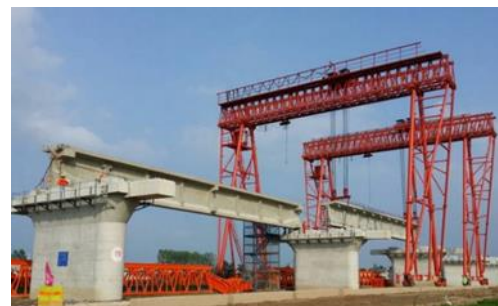
Figure 2 : Pose de poutres par portique Figure 2: Installation of beams by gantry
