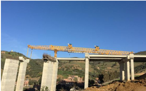
Figure 3 : Pose de poutres par lanceur de poutre
