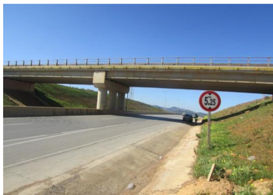
(a) Vue en élévation de l'ouvrage
