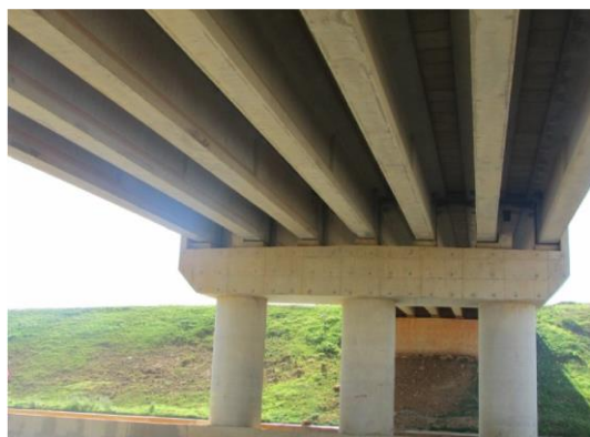
(b) Vue de dessous de l'ouvrage
