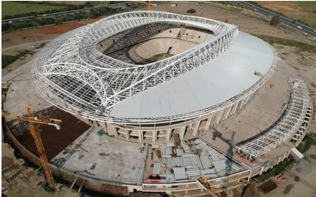
Figure 1. Vue générale du stade de Baraki
