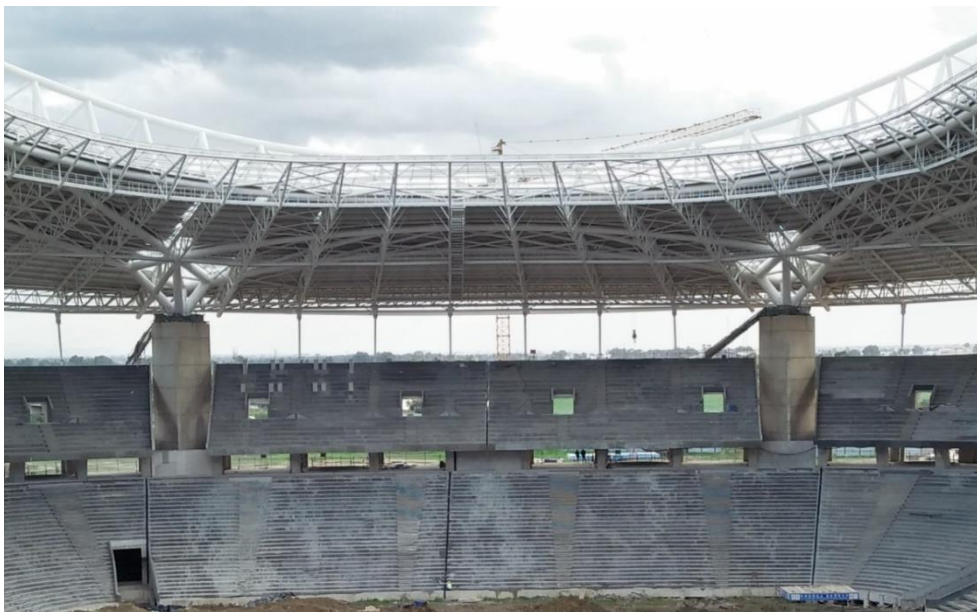
Figure 3. Vue de face des gradins du stade avec la toiture en charpente métallique.
